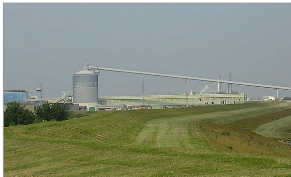
Aluminium-Fabrik mit Biomasse, Niederlande
