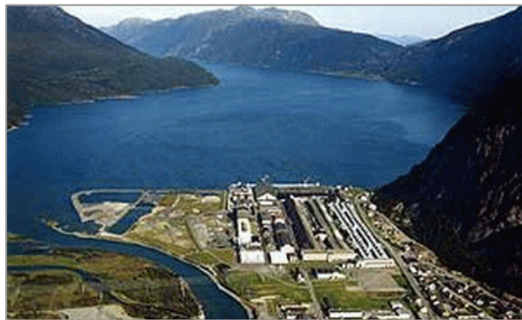
Aluminium-Fabrik mit Wasserkraft, Norwegen
