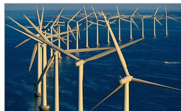
Aluminium-Fabrik mit Wind- und Wellenkraft, UK
